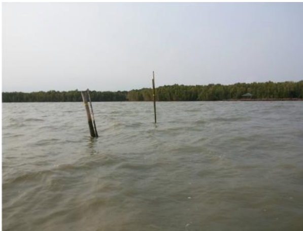
ภาพที่ 2.5.8 ซ่อมหลักวัดระดับพื้นทะเลใหม่หมู่ 2 ระหว่างปากคลอง 7-8
