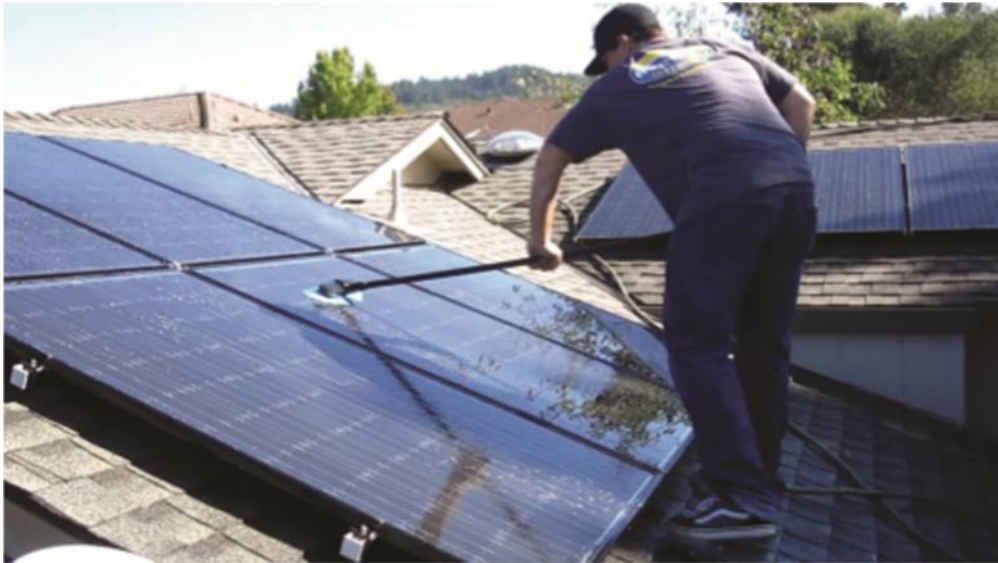
ภาพที่ 10 การเช็ดทำความสะอาดแผงเซลล์แสงอาทิตย์
