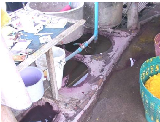
ภาพที่ 10 บ่อพักน้ำจากกระบวนการผลิตก่อนการสูบทิ้ง
